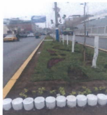
Imagen N°31: Instalación de Área verde en la Av. Canevaro
