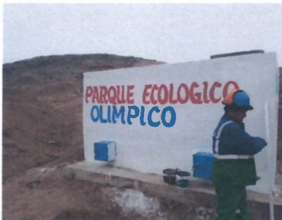
Imagen N°61: Pintado de reservorio parque Ecologico
