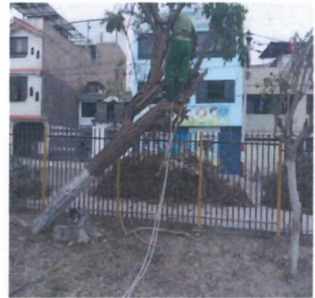
Imagen N°64: Extracción de árbol peligroso parque Parado de Bellido
