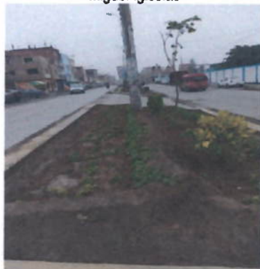
Imagen N°30: Instalación de áreas verdes Avenida Miguel Iglesias
