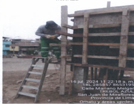
Imagen N°62: Construcción de reservorio en el parque Trebol azul
