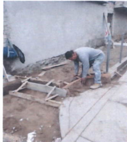
Imagen N°56: Construcción de Sardineles en la av. Alejandro Tirado
